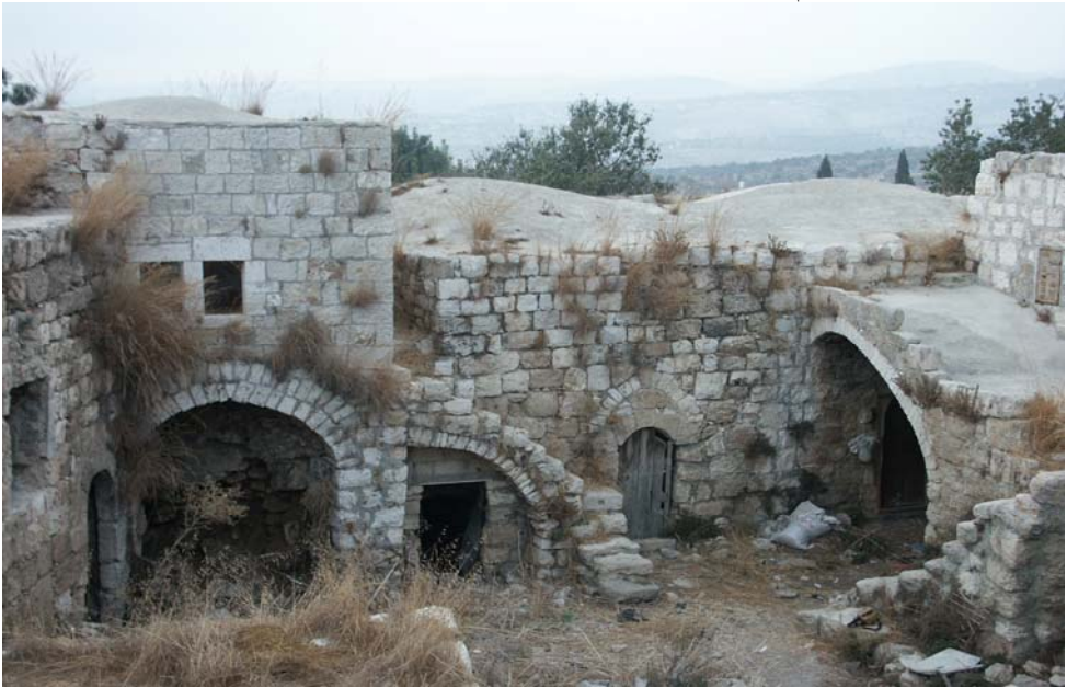
شكل (١٢): حوش دار ناصر - صفّا، تظهر القباب المنخفضة، وعليها طبقة إسمنتية. (تصوير الباحث في عام ٢٠٠٤م).
